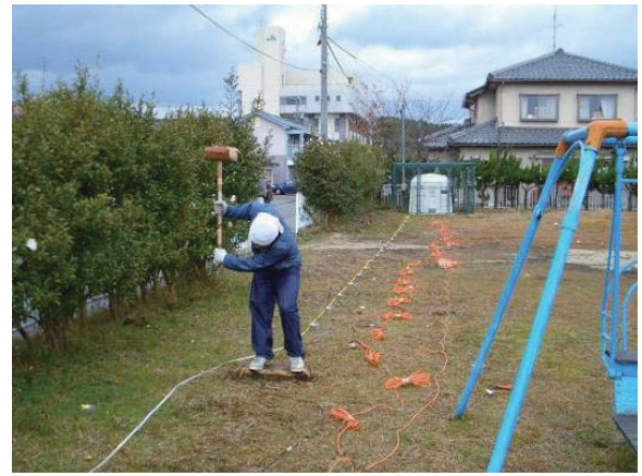
図-3 石川県穴水町での調査の様子
