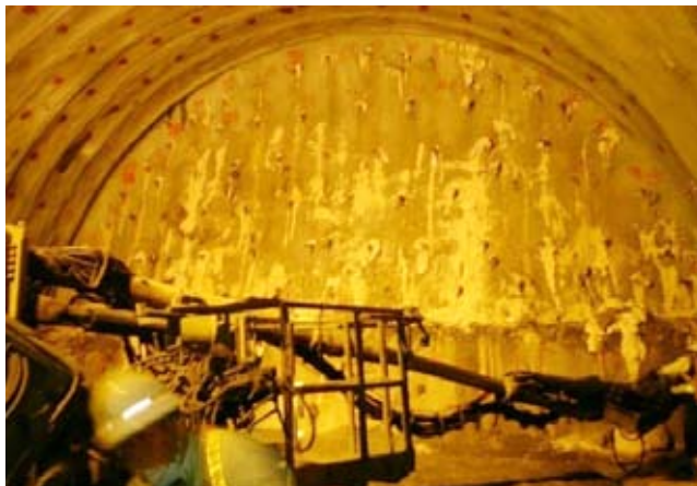
図-3 鏡ボルト打設後の切羽
