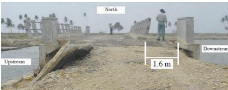
写真-4 移動した橋桁
