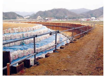
写真-4 出石川直轄区間における破堤地点の応急復旧状況
