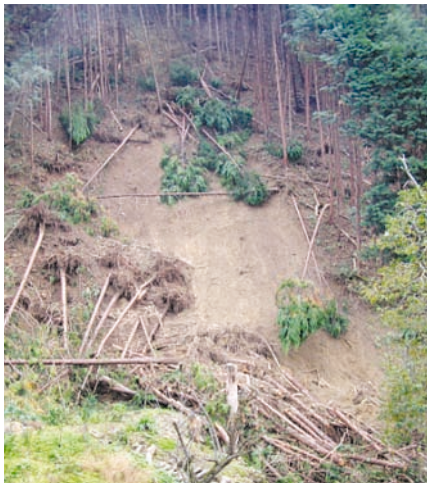
写真-1 円山川上流域山地斜面の表層崩壊
