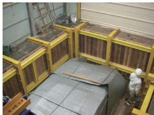
図-5 石室解体、石材取り出しに際して設置された木製矢板とH鋼の腹起こし(石室には保護用カバーがかけられている)
